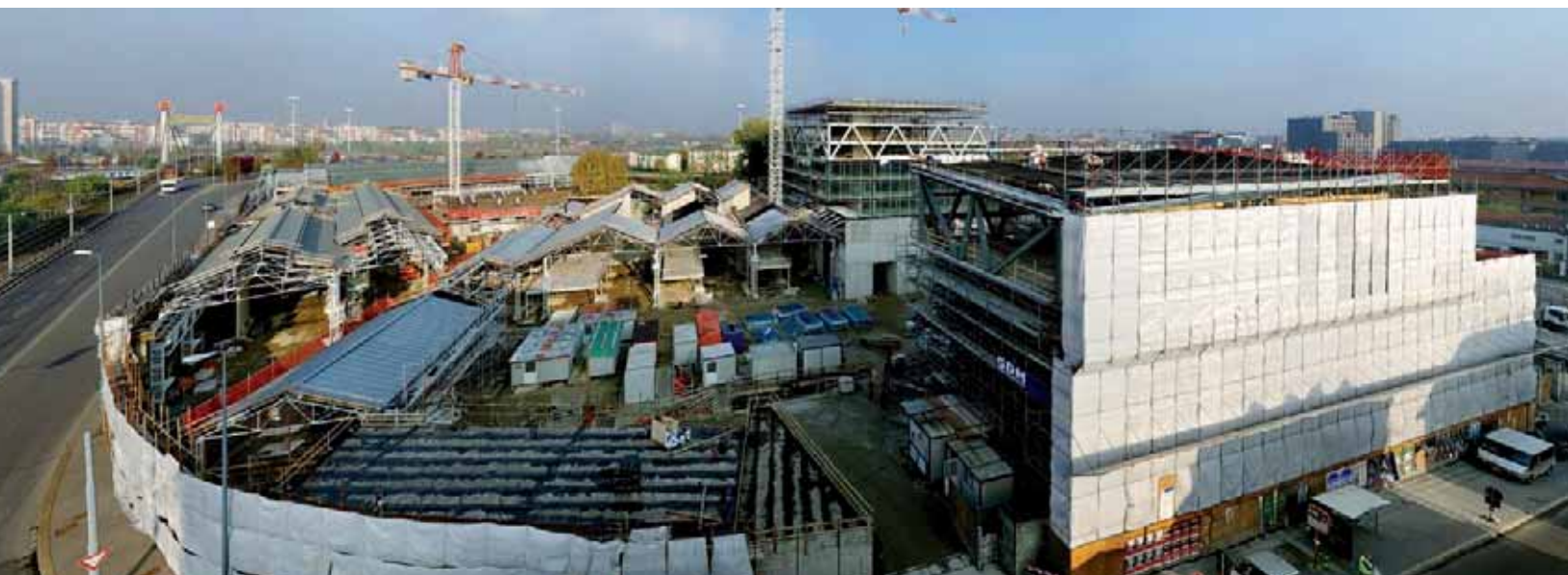
Foto del cantiere vista da Via Varesina angolo Via Filippo Palizzi
