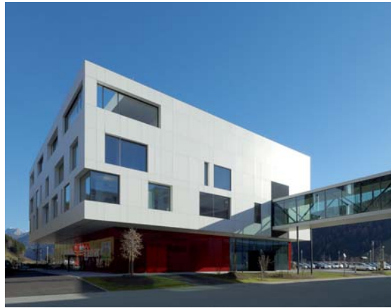
01 A. LOACKER Palazzina uffici e punto vendita luogo: A - Heinfels realizzazione: 08.2008 - 04.2009 Architetto Ralf Dejaco I - Bressanone
