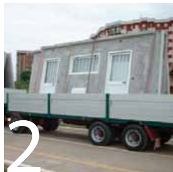
trasporto in cantiere
