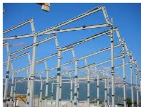
La costruzione del nuovo stabilimento della Ditta "ATZWANGER S.p.A." collocato nella Zona Produttiva "Ex-Magnesio" a Bolzano Sud, è un chiaro esempio di edificio a struttura metallica costruito nel totale rispetto delle norme sismiche.
