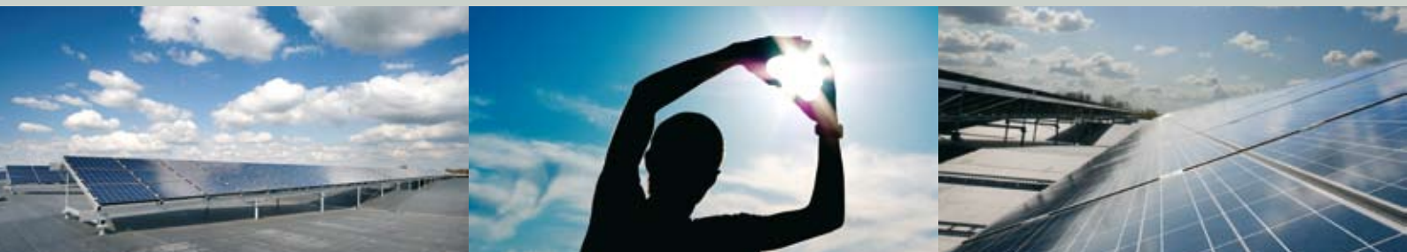
Reynaers - pannelli solari sul nuovo centro di distribuzione - Belgio
