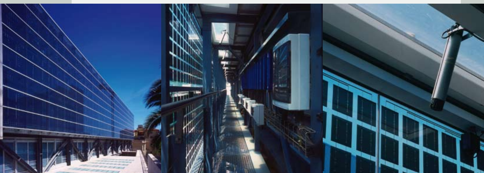
Facciata continua con pannelli fotovoltaici - La Salle - Barcellona, Spagna (Architetto : Robert y Esteve Terradas Muntanyaola)
